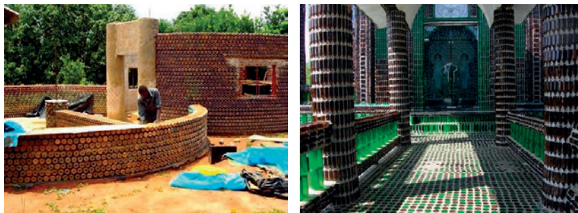
Figura 38. A destra fase di costruzione della casa con bottiglie di plastica, in Nigeria; a sinistra il tempio di Wat Pa Maha Chedi Kaew in Thailandia.
