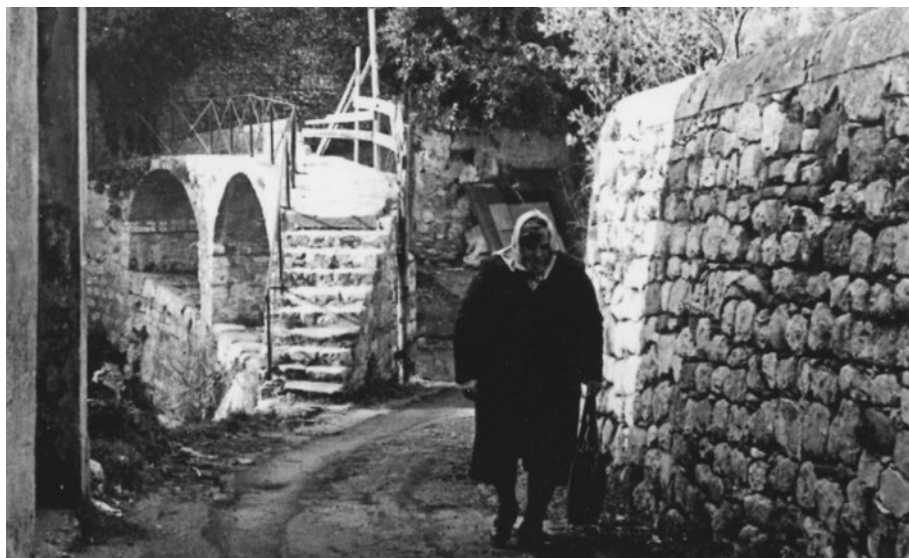
Il Ponte alla Parancola, dove si notano le assi di legno come spalletta.
