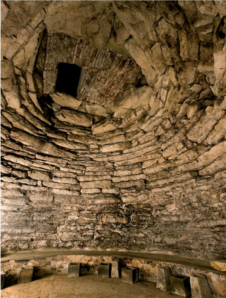
Tomba della Mula: struttura interna della thòlos con il tamponamento in mattoni dell'anello superiore, eseguito in età moderna.
